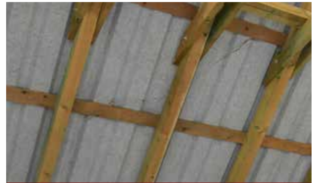
A szerkezet megfelelő kialakítása a hatékony és állandó kiszellőztetéshez.
